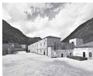
Recupero del Forte di Fortezza Fortezza (BZ)
